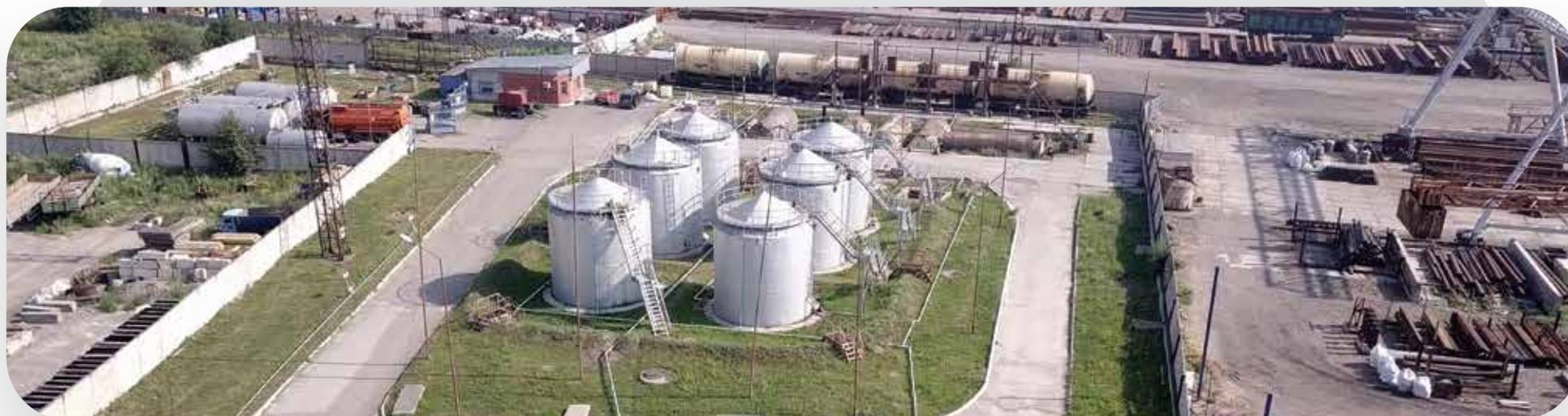
С момента покупки нефтебазы проведена полная реконструкция резервуарного парка светлых и темных нефтепродуктов, построена закрытая (замкнутая) производственно-ливневая канализация с системой фильтрации.
